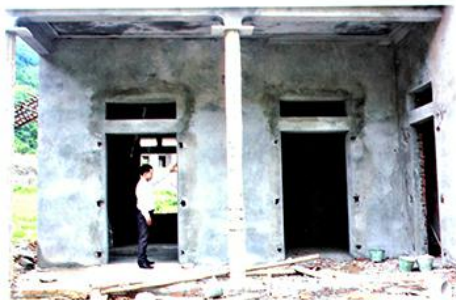
Trưởng khu Lê Văn Chiêu thăm, kiểm tra ngôi nhà đang xây dựng tại khu tái định cư Hạ Thành
