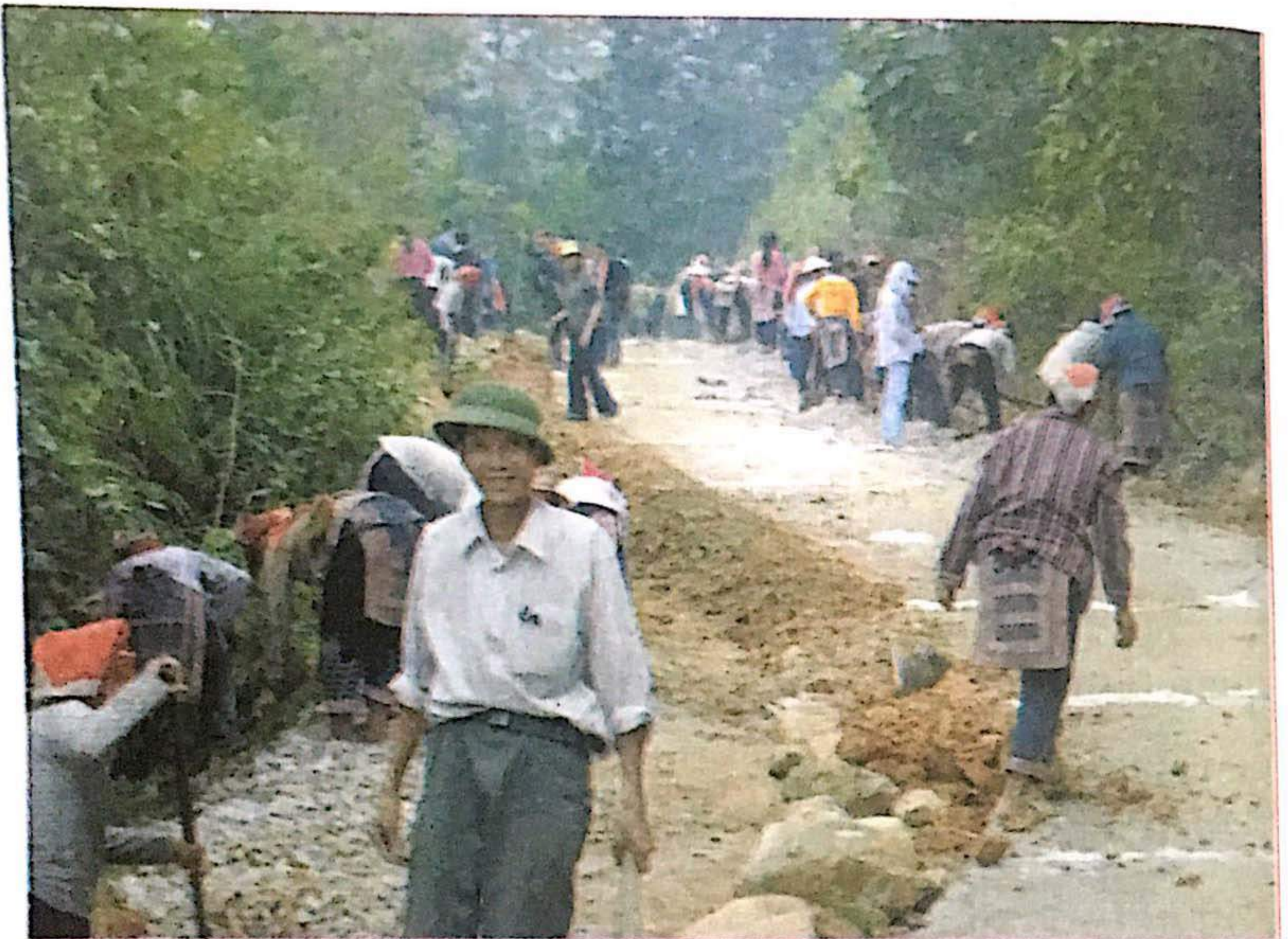
Nhân dân thôn Trát 1 tích cực hoàn thành đường giao thông nông thôn.
