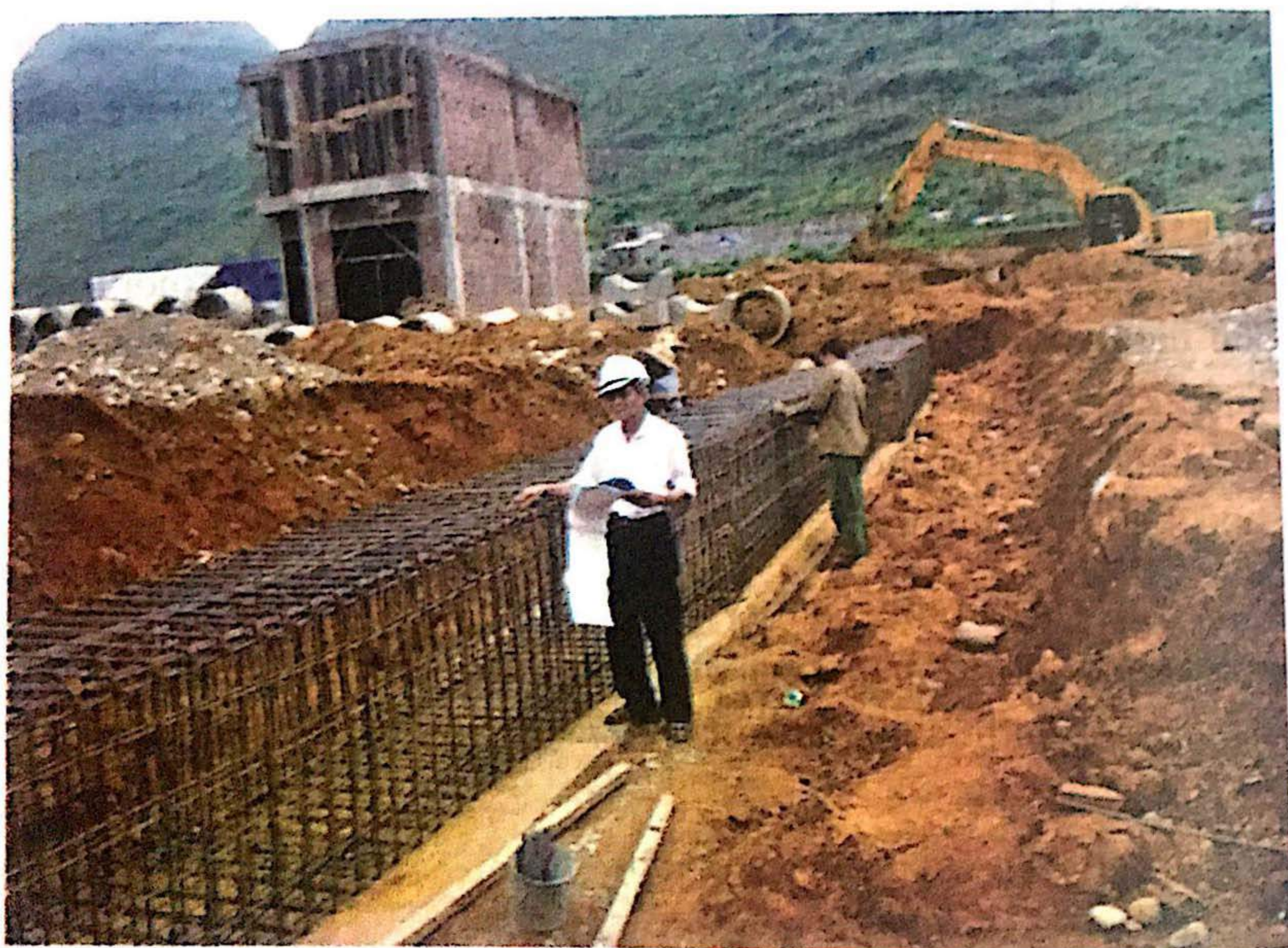
Ông Hoàng Quyền đang kiểm tra chất lượng công trình
