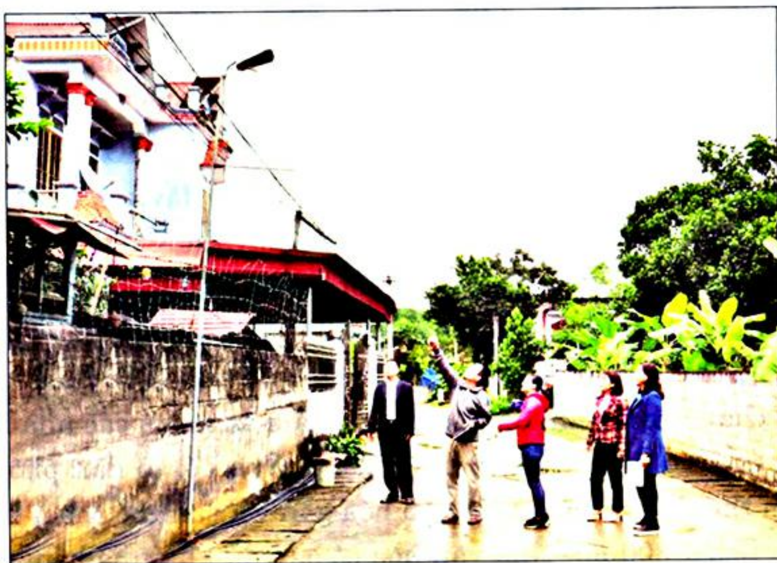
Hệ thống điện chiếu sáng được lắp đặt ở các ngõ, xóm tổ dân phố Tân Quang, thị trấn Tân Yên, huyện Hàm Yên
