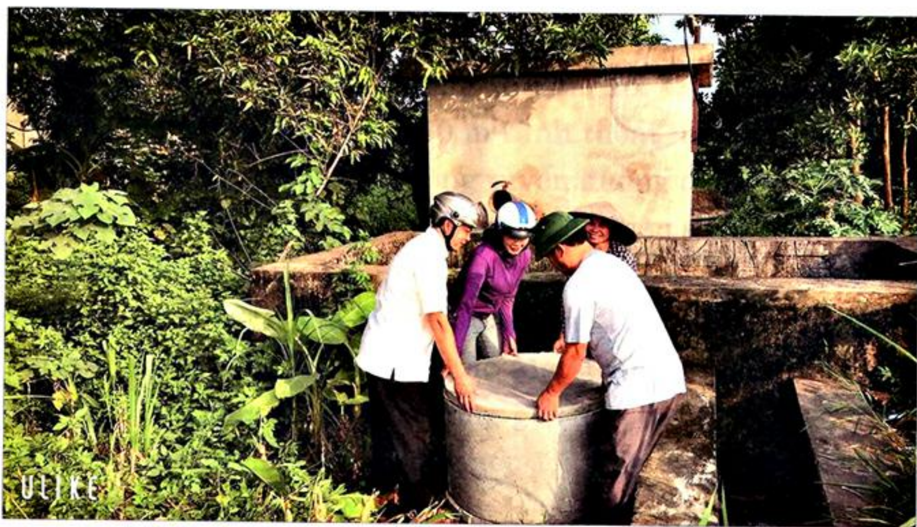
Nhân dân Tổ 9 phường Nông Tiến, thành phố Tuyên Quang lắp đặt bể đựng bao bì thuốc bảo vệ thực vật để bảo vệ môi trường
